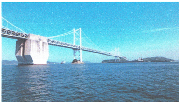
写真1：備讃瀬戸大橋
